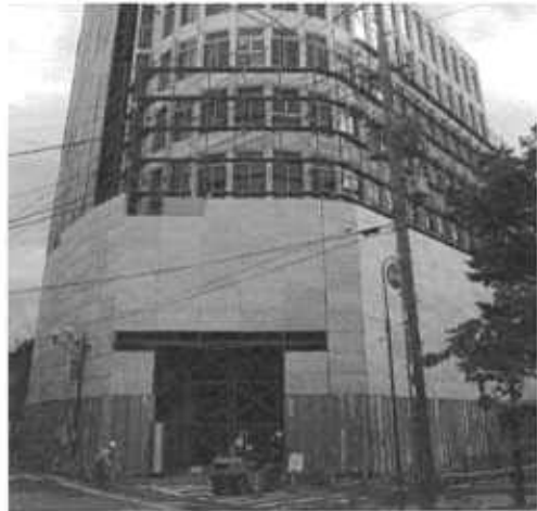
現在、旧寿屋は解体作業中です。今年の11月ごろ、その姿は消えてしまいます。
