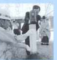
安全を祈願し杭打ち
