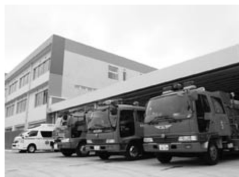
鶴岡西町に完成した新消防庁舎
