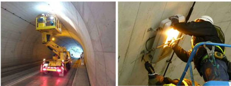
定期点検の様子
