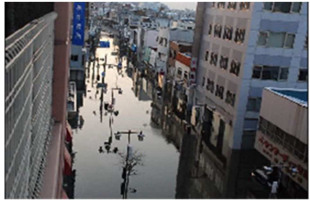
東日本大震災時の石巻市庁舎から水没した市街地を臨む
