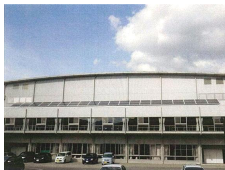
防災拠点再生可能エネルギー導入事業(総合体育館)
