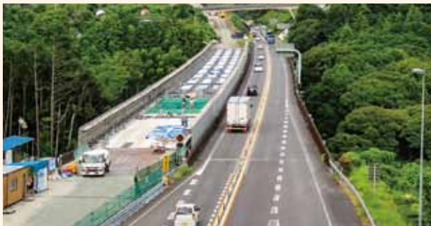
▲臼杵～津久見IC間4車線化工事の様子
