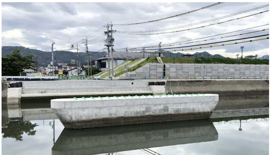
▲女島橋架替工事の様子
