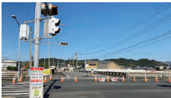
▲ 女島橋架替工事に伴う車両通行止め (令和元年 10 月 15 日から)
