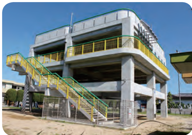
▲ 池船津波避難タワー
