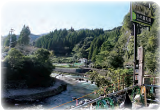
▲ 市道小半線の橋梁設置予定箇所を望む (令和3年3月末 開通をめざす)
