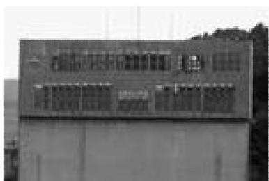
▲改修予定のスコアボード
