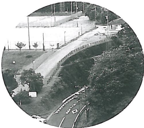
▲ 防球ネット整備予定箇所
