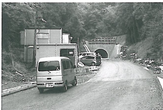
工事中的新八明トンネル(海崎側)
