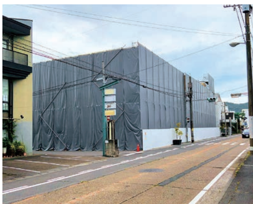
▲ 解体中の旧マルシヨク中央店
