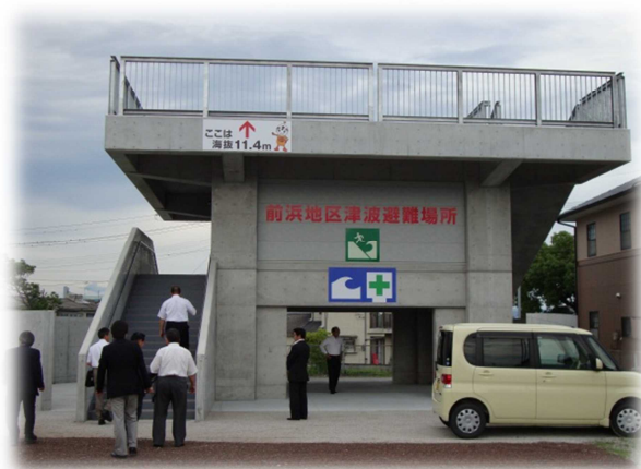
▲津波避難タワー
