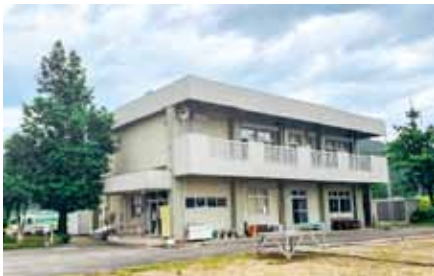
▲老朽化が進む木立地区公民館
