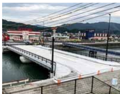
▲女島橋の現況
