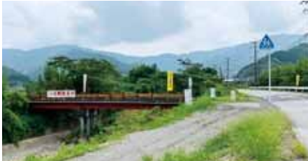
▲ 管理者不明橋(勝手橋)
