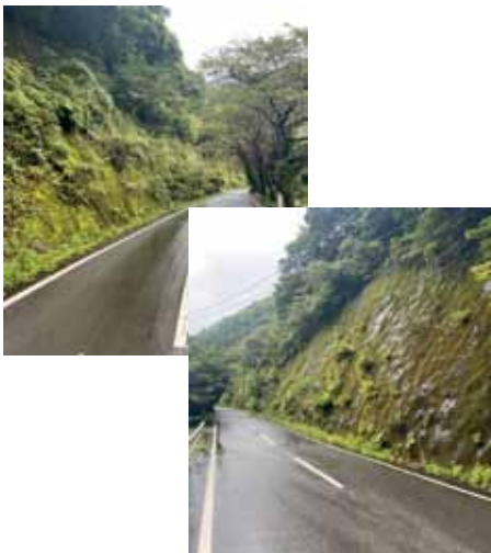
▲市道色利尾浦線の法面
