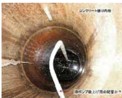
▲ 彦陽中学校にある井戸の内部の様子
