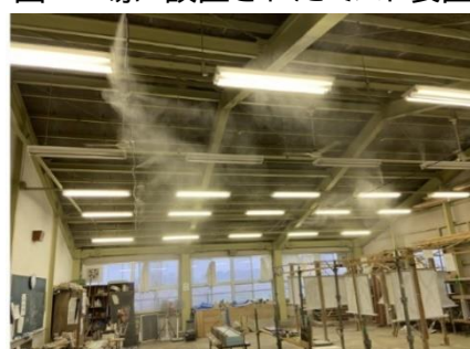
図 工場に設置されたミスト装置
