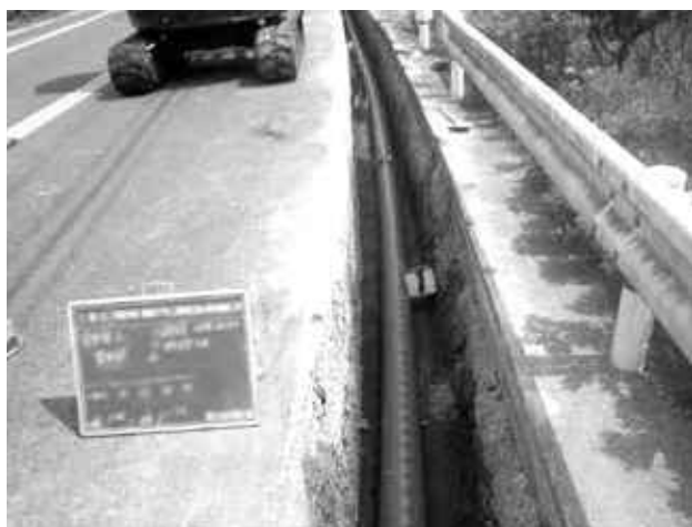
老朽化した管路の更新による耐震化①
