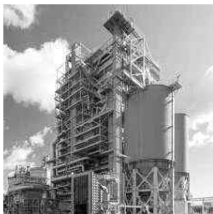
バイオマス発電所
