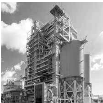
バイオマス発電所
