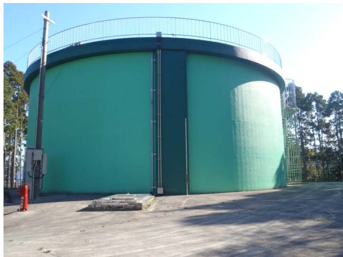
〔耐震性を有する施設（堅田第2配水池）〕
