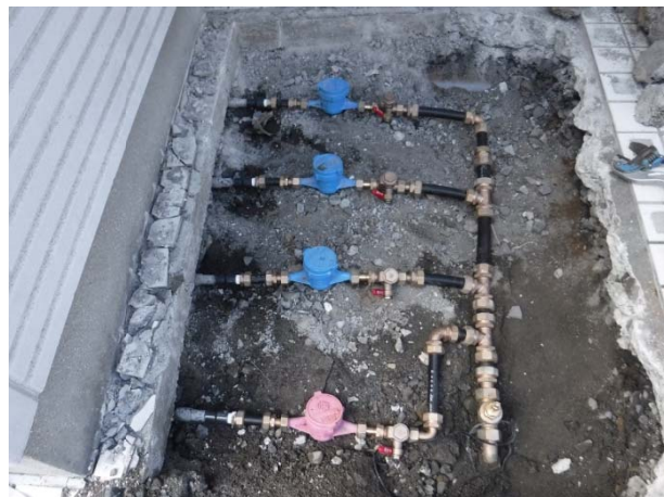
〔鉛製給水管更新の様子〕
