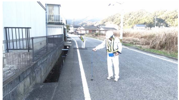
〔漏水調査の様子〕
