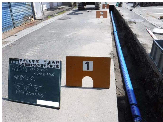
〔配水管布設替の様子〕
