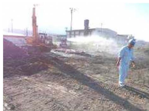
埋設物掘出作業（消臭剤噴霧）
