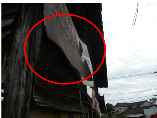
鉄製看板落下の危険性
