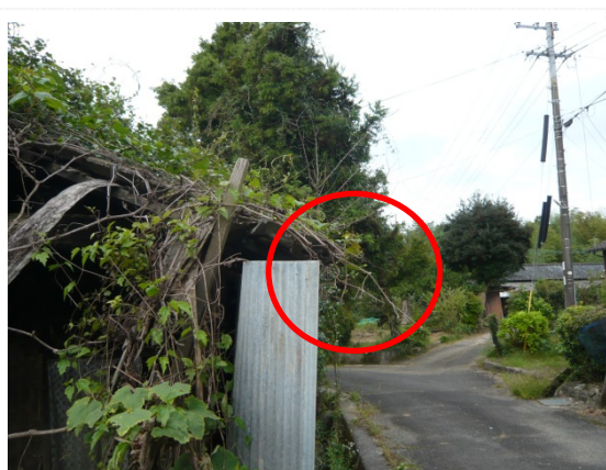
枝等が道路にはみ出している
