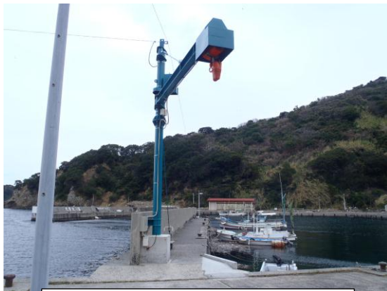
＜漂着ゴミ回収用ユニック設置＞ H24.10.8 完成 1.0t 吊設置型
