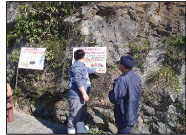
看板設置作業：深島（R2.3.12）
