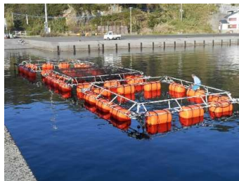
出荷調整生け簀の改修 (R3. 3. 25)
