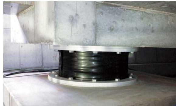
県内の自治体庁舎では初となる免震構造を取り入れています。
