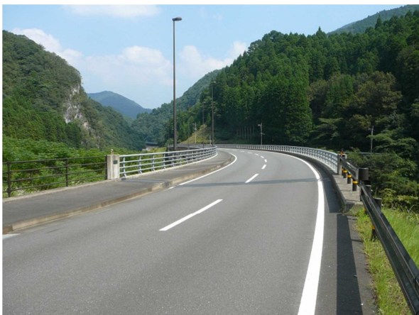
■道路の整備（主要地方道三重弥生線）
