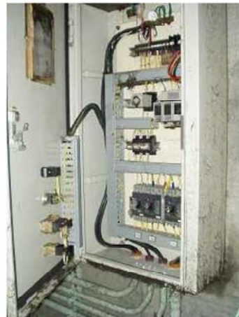
1 階に設置され浸水した計器類やサーバー等 (石巻広域クリーンセンター) 宮城県石巻市
