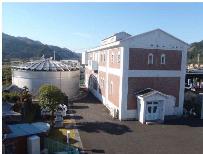
[上岡第1浄水場]
