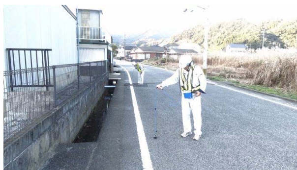
[漏水調査の様子]
