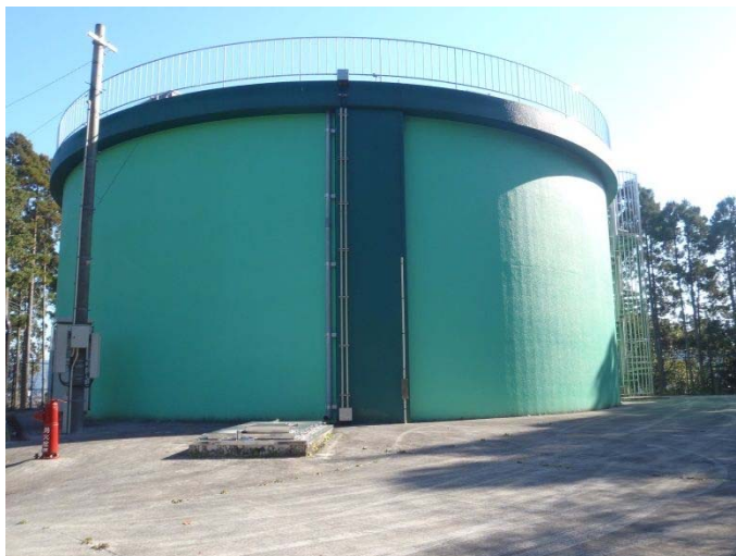
〔耐震性を有する施設（堅田第2配水池）〕
