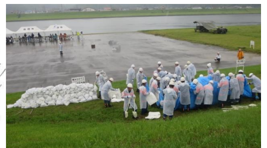
水防団による積み土のう工法
