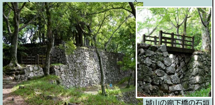
城山の廊下橋の石垣
