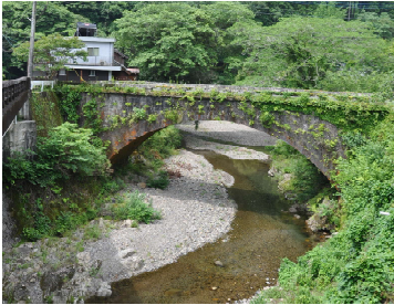
石造アーチの宇藤木橋
