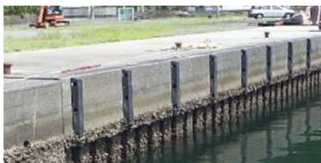
長寿命化対策前の物揚場（鋼矢板式）
