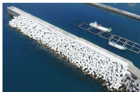
消波ブロック設置による防波堤の機能強化（元猿漁港）
