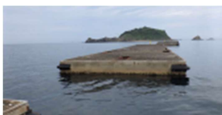
鶴見地区の浮消波堤
