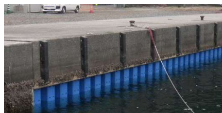
長寿命化対策（防食工）後の物揚場
