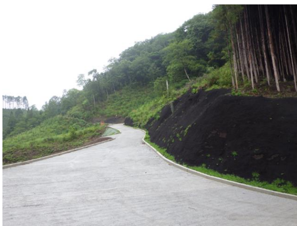
開設中の林道岸ノ上庵ノ木線（直川）
