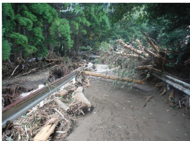
台風により林道のガードレールに溜まった流木等
