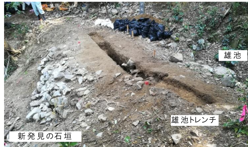
雄池トレンチの調査状況
