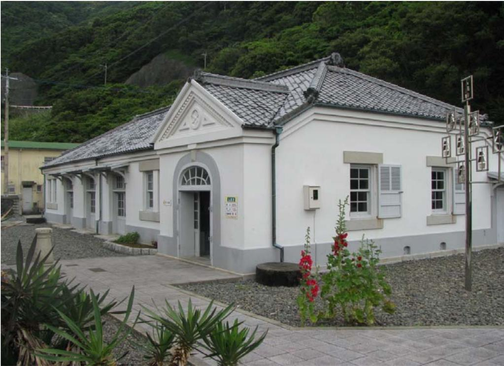
旧水ノ子灯台吏員退息所は明治36年(1903)12月20日に完成した。レンガ造り平屋建てで、5,237円をかけて建設され、逓信省の管轄下にあったので、軒瓦の全てに「〒」のマークが付けられており、当時としては大変しゃれた洋風建築であった。内部は5世帯の住居に区画され、南面に切妻造の便所棟が付属する。アーチ型の天窗を開く切妻造の玄関や上げ下げ窓が外観を特徴づける。昭和58年(1983)に旧鶴見町に払い下げられ、近年の改修で海事博物館(現「水の子島海事資料館」として再生された。当時の長屋建の部屋をリメイクし、灯台の貴重な資料、昔の漁具や海の生活を知る資料が展示されている。
