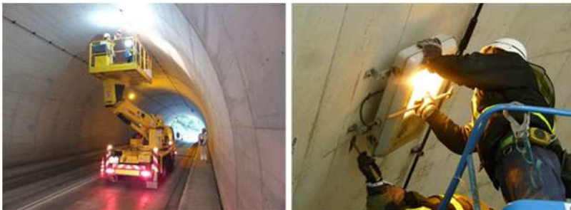
定期点検の様子
