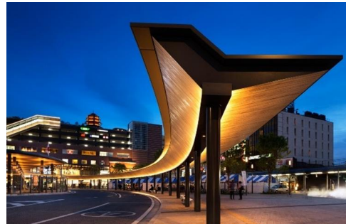
大分駅北口駅前広場シェルター工事
