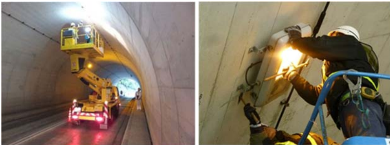
定期点検の様子
