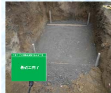
⑤基礎工完了
