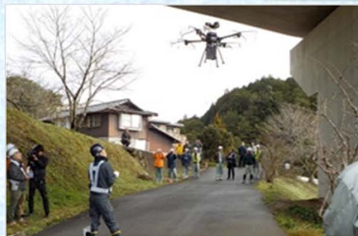
ドローンによる施設点検
