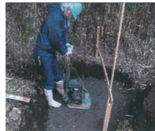
④基礎碎石 転圧状況
