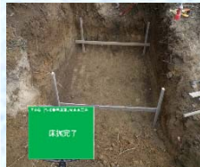
③床掘完了
