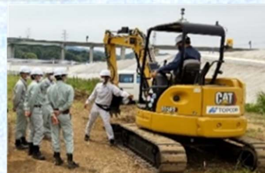
ICT建設機械による施工
