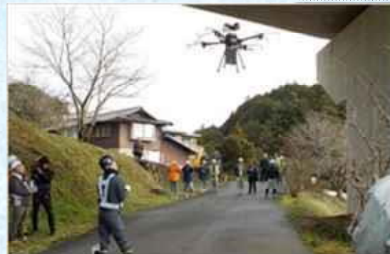
ドローンによる施設点検
