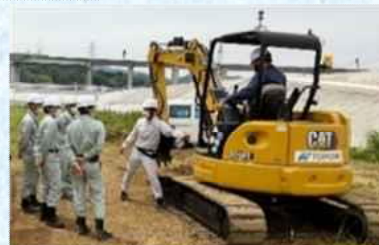
ICT建設機械による施工
