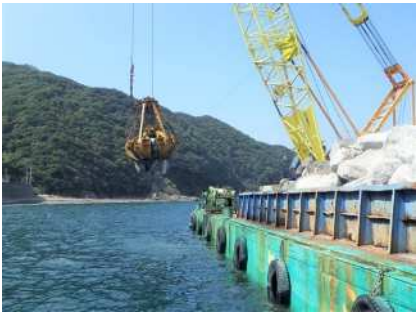
増殖場造成事業（自然石の投入）
