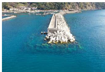
消波ブロック設置による防波堤の機能強化
