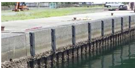
長寿命化対策前の物揚場（鋼矢板式）
