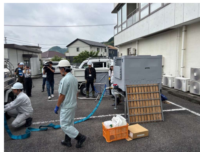
組立式給水タンク（津久見市）に充水
