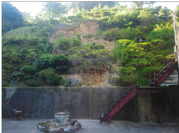
林地崩壊防止対策事業（施業前）
