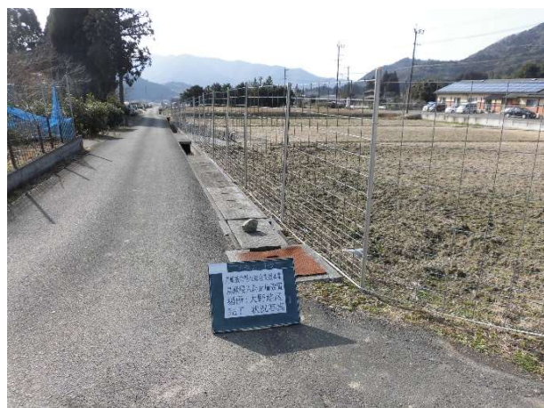
集落に設置した侵入防止柵の様子
