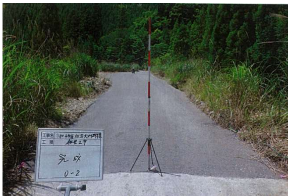
鉄鋼スラグによる道路舗装
