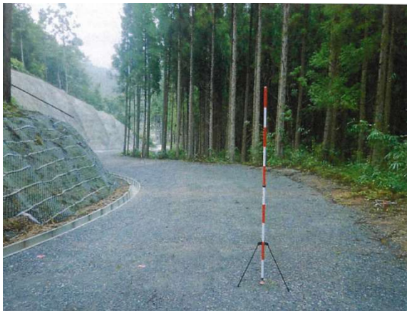
開設中の林道岸ノ上庵ノ木線（直川）
