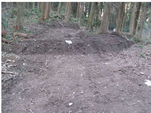
横断排水処理をした作業道
