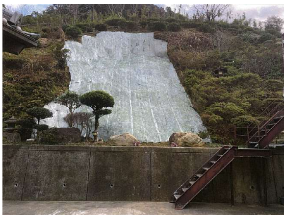
林地崩壊防止対策事業（施業後）
