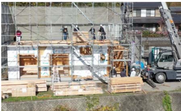
地域材パネル工法で建築している住宅
