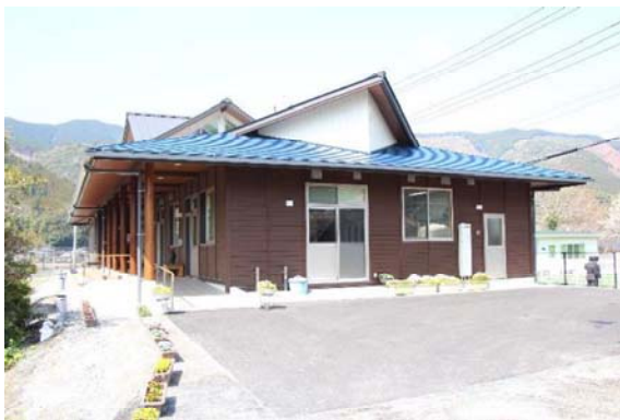
市産木材を使用して建設した 青山コミュニティセンター
