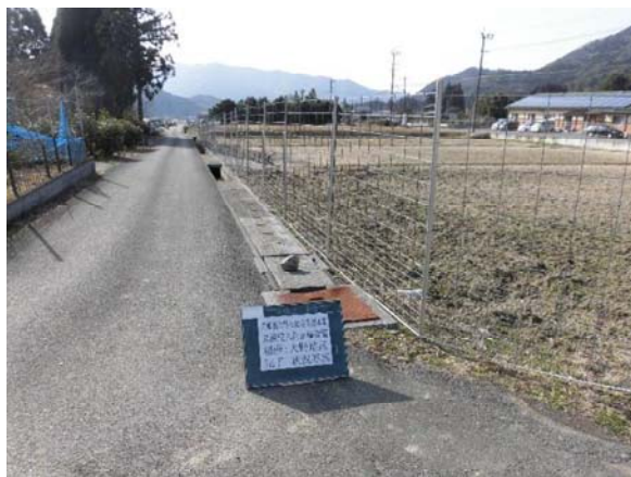
集落に設置した侵入防止柵の様子（佐伯市木立）
