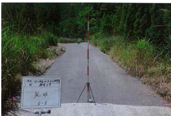
鉄鋼スラグによる道路舗装（宇目木浦内）
