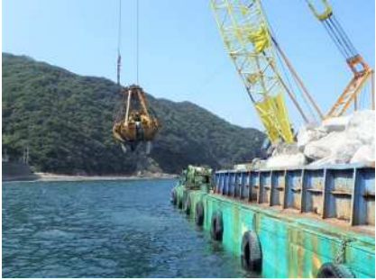
増殖場造成事業（自然石の投入）
