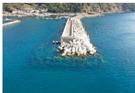
消波ブロック設置による防波堤の機能強化
