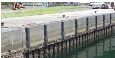
長寿命化対策前の物揚場（鋼矢板式）
