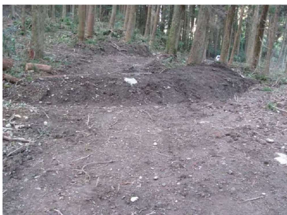
横断排水処理をした作業道（宇目小野市）
