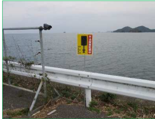
監視カメラによる監視
